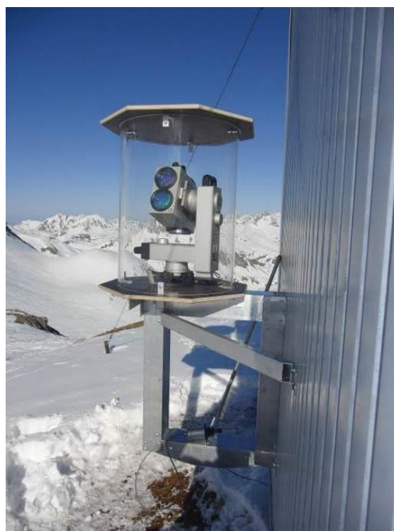
Abbildung 1. TLS Riegl LPM98-2K, mit Wetterschutzhaube aus Plexiglas, an Containerwand verschraubt (Foto: BFW).
