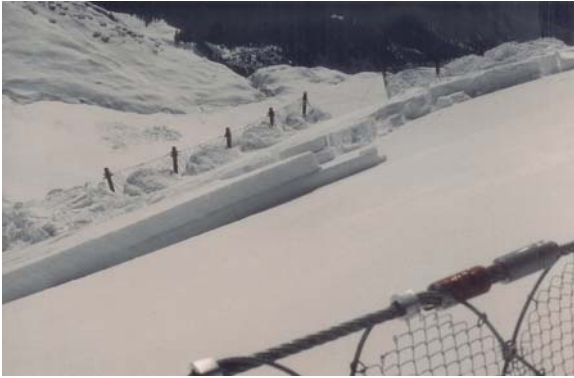
Abb. 3: Lawinenanriss in verbaute Fläche hinein; Lawinenschnee wird von den Schneesetzen teilweise zurückgehalten; im Hintergrund das flachere Gebiet (Bereich Bäll) bevor die Steilstufe gegen Blatten folgt (Foto P. Schwitter).
